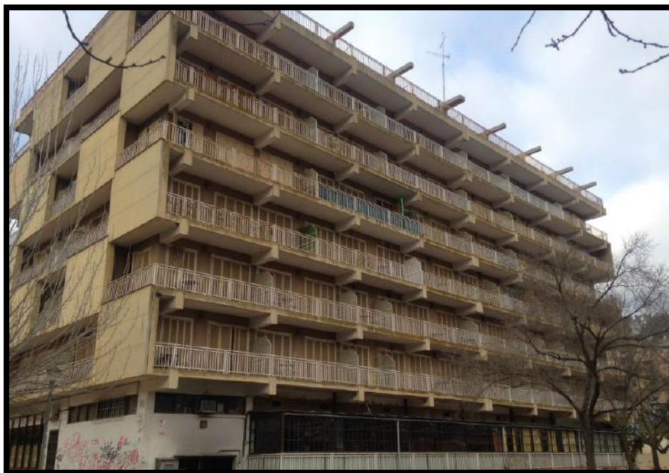
Figura 4. Fotografía del edificio a demoler vista desde el Este.
