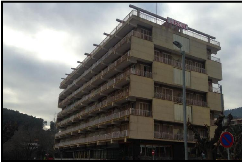
Figura 3. Fotografía del edificio a demoler vista desde el Norte.
