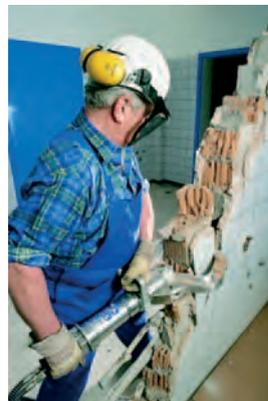
Conforme avanza la demolición de los tabiques se irán levantando los cercos de la carpintería interior.
