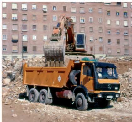
Cuando la demolición es en núcleo urbano, que es lo más habitual, puede ser necesario cortar el tráfico de manera momentánea para la salida del camión, esto se hará siempre por un operario que irá guiando al camión desde fuera.
