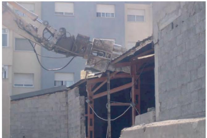
Este equipo dispone además de las cuchillas, de una rótula que permite el giro total de su cabeza; de modo que simplemente por torsión del elemento, el material a demoler se secciona y desmenuza en razón a las exigencias que establecen el conductor de la máquina y el derribista.
