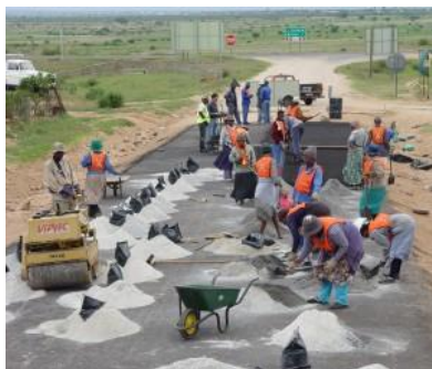
Mano de obra intensiva en el mantenimiento de caminos
