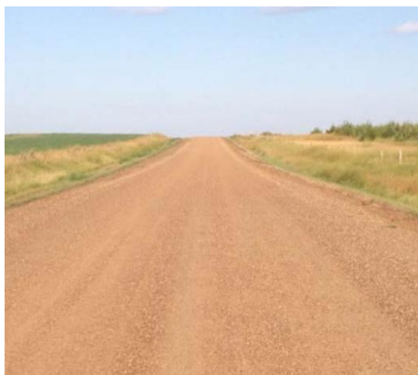
Foto 4 - Camino con un perfil transversal deseable. Con suficiente ancho en la zona de camino y pendientes de calzada, banquinas y cunetas adecuadas. Este camino permite el rápido drenaje del agua superficial y responderá correctamente incluso en zonas de altas precipitaciones (mayores a 1200 mm/año).
