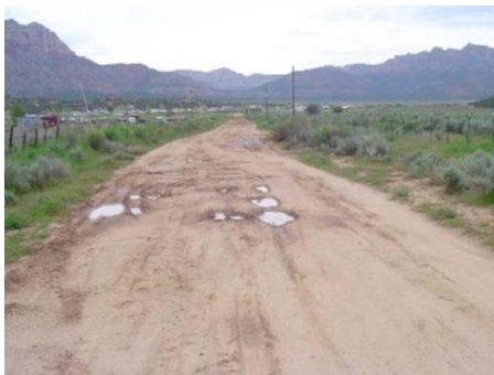
Foto 3 - Camino problemático, con cota roja negativa, que no permite el drenaje de la calzada, puesto que no posee cunetas ni pendientes adecuadas en calzada y banquinas. Este camino responderá de forma deficiente incluso en zonas de bajas precipitaciones (menores a 300 mm/año).
