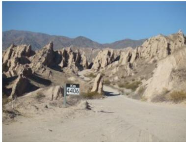
**Definición:** Camino de montaña es aquel que se desarrolla sobre un terreno con variaciones en altura, longitudinal y transversalmente; por lo cual se necesitará realizar trabajos de excavaciones y rellenos, a fin de obtener una alineación tanto horizontal como vertical adecuada.
