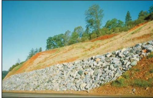
Contrafuerte de roca para contención en zona de fallas de talud.
