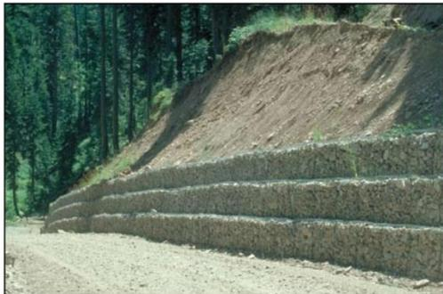
Gaviones como estructura de contención utilizando material local
