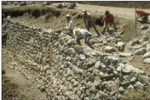
Estabilización física de taludes
