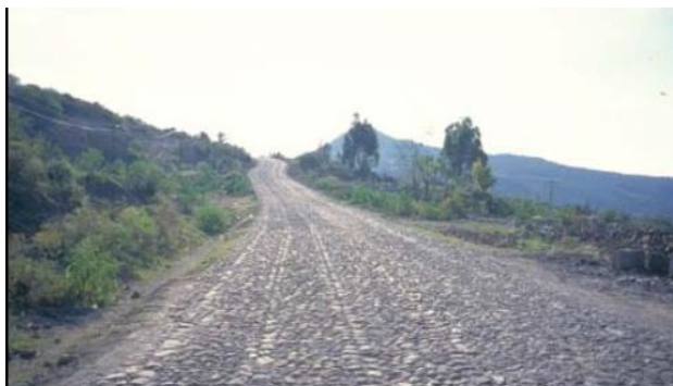
Foto 1: Camino bien diseñado de "impacto mínimo" que tiene una especificación adecuada para su uso, así como una superficie de rodadura estabilizada
