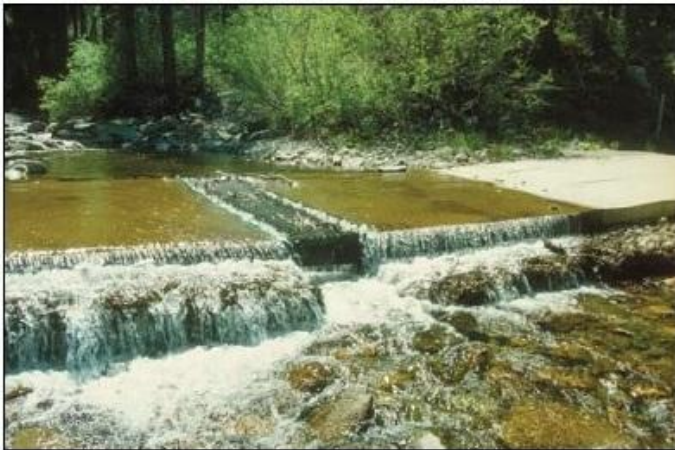
Foto 13: Vado mejorado con una abertura de cajón de concreto para pasar los flujos en estiaje, para mantener el tránsito fuera del agua la mayor parte del tiempo, minimizar los retrasos en el tránsito y permitir el paso de peces.
