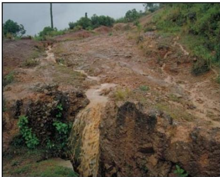
Foto 23: No deje las zonas alteradas o desgastadas por la erosión expuesta a la lluvia y escurrimientos. Emplee medidas de control de la erosión para proteger la zona y cuidar la calidad del agua.
