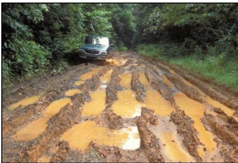
Foto 4: Evite las actividades de construcción y de otro tipo durante las temporadas de lluvia siempre que sea posible. Alternativamente, añada estabilización de la superficie y del drenaje en zonas de suelos pobres o blandos, para su uso en cualquier tipo de clima.
