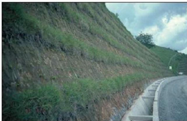
Foto 24: Uso de pastos, plantados en hileras, para proporcionar estabilidad a la superficie del talud y control de la erosión en cortes escarpados del camino.
