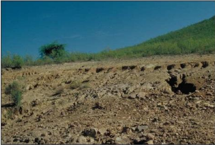
Foto 21: Esta zona de préstamo al lado del camino carece de control de drenaje y de la erosión. El desarrollo de bancos a un lado del camino puede resultar económico y útil, pero las áreas deben esconderse si es posible, y la zona debe rehabilitarse una vez concluido el proyecto.
