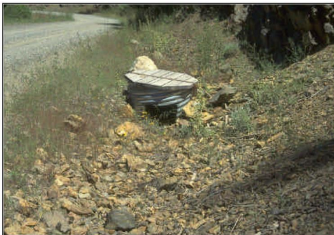
Foto 7: Cuneta protegida con enrocamiento y boca de caída para controlar el agua y evitar la socavación de la cuneta.
