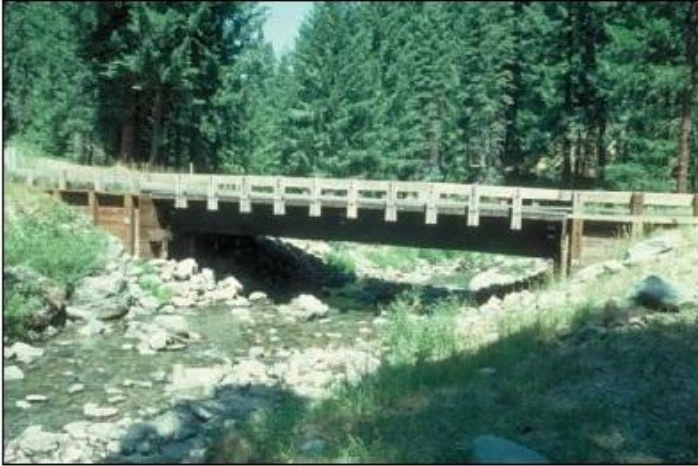
Foto 17: Aquí se muestra un puente de madera tratada bien construido, con buena protección de las márgenes del arroyo y un claro adecuado para minimizar los impactos del flujo del canal. El borde libre que se muestra es marginalmente adecuado.
