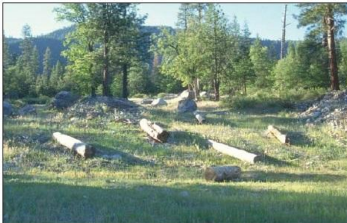
Foto 22: Un banco de préstamo que ha sido rehabilitado y reforestado. Reconfigure, drenes y restaure los bancos de préstamo y las canteras, una vez que se han explotado los materiales útiles y el uso de la zona ha terminado.
