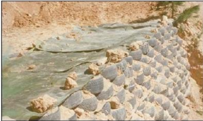
Foto 19: Muro de contención de tierra estabilizada mecánicamente (MSE), como Tierra Armada con la fachada protegida con llantas o capas de refuerzo de geo textiles. Se usa para ampliar el camino en una zona con fallas en el terreno. Las estructuras tipo MSE son a menudo las estructuras de contención menos costosas disponibles. También se usan a menudo muros de malla de alambre soldado.
