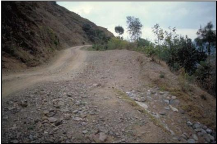
Foto 6: Use un vado ondulante superficial como dren transversal, para desalojar el agua de la superficie del camino de manera eficiente y económica, sin tener que usar tubos de alcantarilla.
