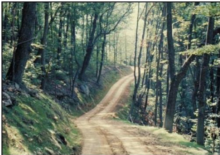
Foto 2: Localice los caminos de tal manera que se adapten a la configuración del terreno natural y deje ondulaciones que permitan dispersar el agua frecuentemente.
