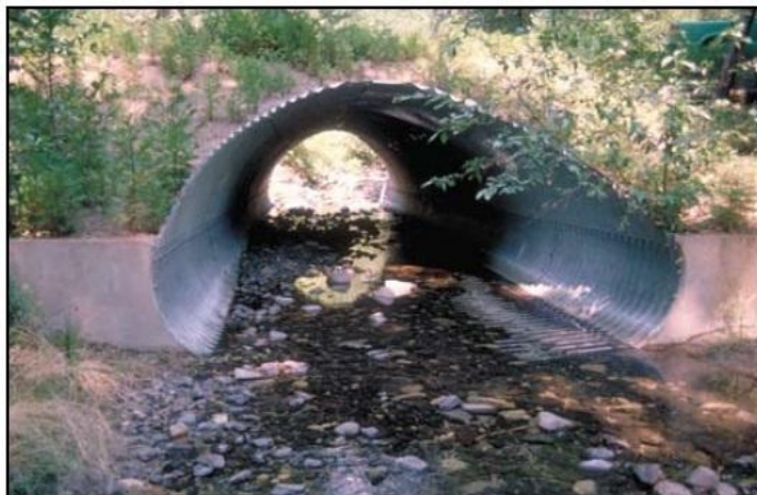
Foto 10: Use estructuras con el cauce natural como fondo, tales como arcos sin fondo, alcantarillas de cajones de concreto o tuberías en arco colocadas por debajo de la elevación del fondo del arroyo, para promover la migración de peces y minimizar los impactos al arroyo.
