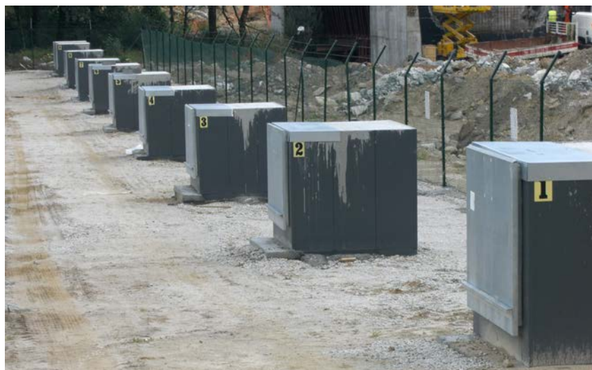
Figura 137: Instalación de polvorines en obra (Ferrimax)
