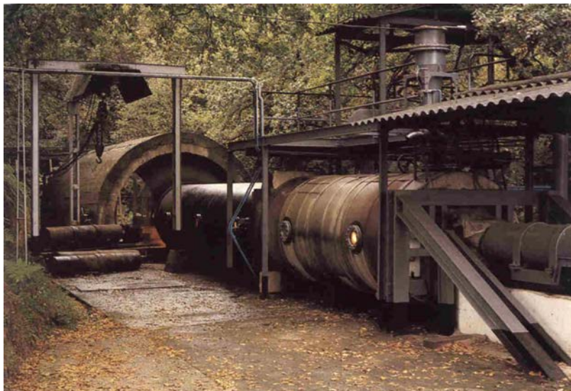
Figura 51: Galería de pruebas para explosivos de seguridad. Campo de tiro de ATXE (Galdácano, Maxam)
