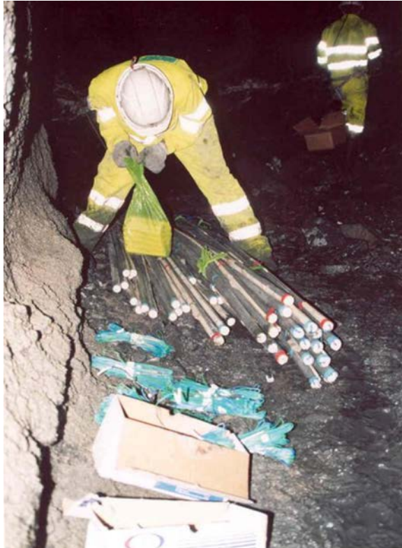
Figura 108: Cañas preparadas para la carga de la voladura
