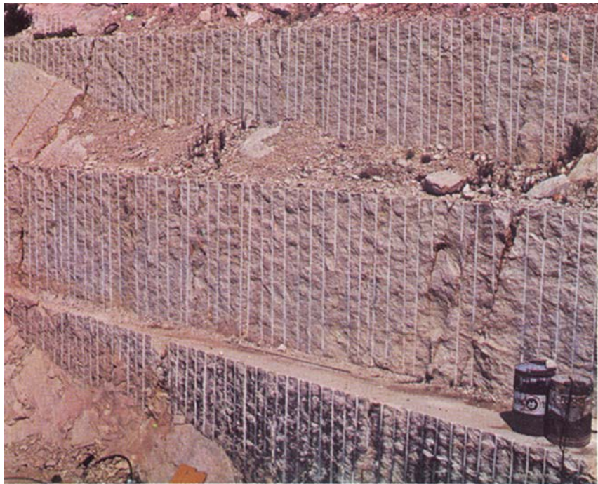
Figura 96: Resultado de una voladura de contorno
