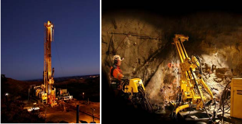
Figura 38: Equipos de sondeos de superficie y de interior
